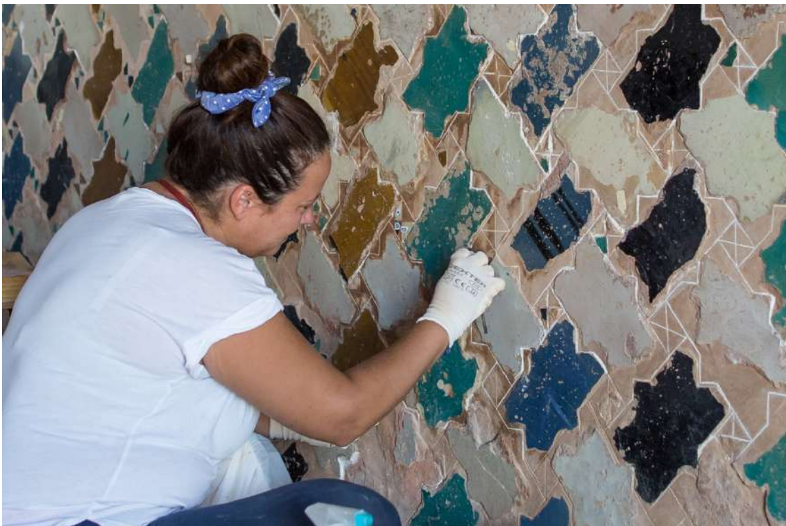
Restauración de Palacio Comares
