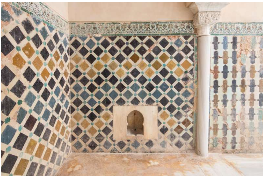
Obras de los Baños
