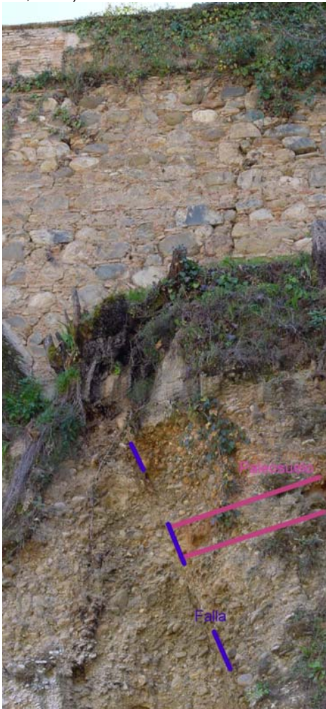
Figura 2: Rotación de un nivel de paleosuelo producida por una falla. Obsérvese que la cerca por encima de la falla está rota.
